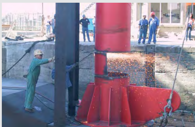
Coupe du support au gaz - Oxicorte del soporte
