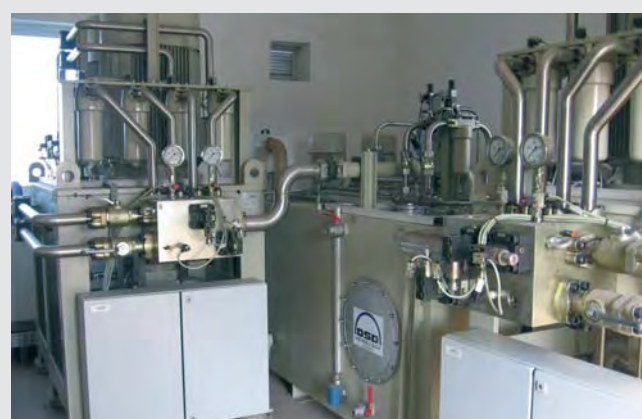
Agrégats hydrauliques - Unidades hidráulicas
