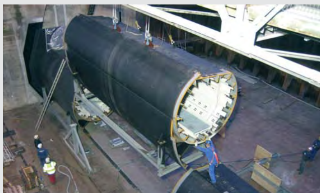
Montage cylindre - Montaje de la compuerta de tambor
