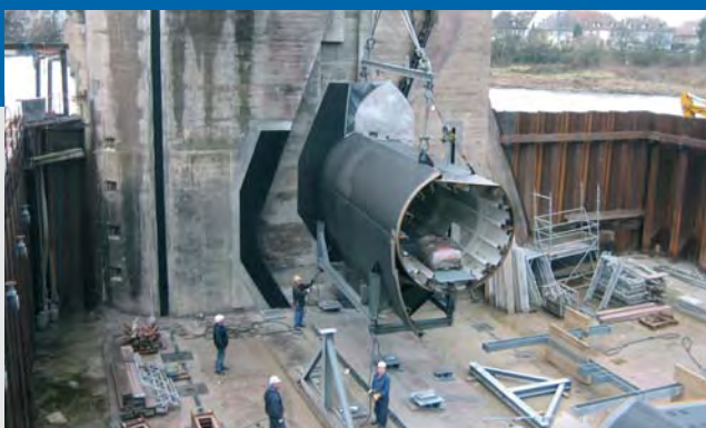
Mise en place cylindre - Colocación de la compuerta de tambor
