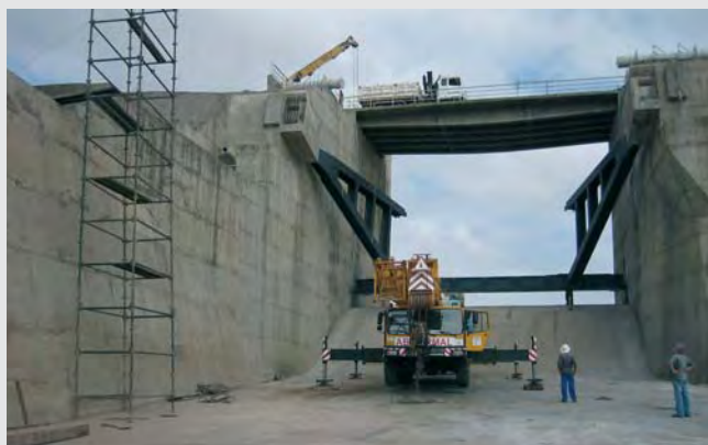
Montage vanne segment - Montaje de las compuertas radiales
