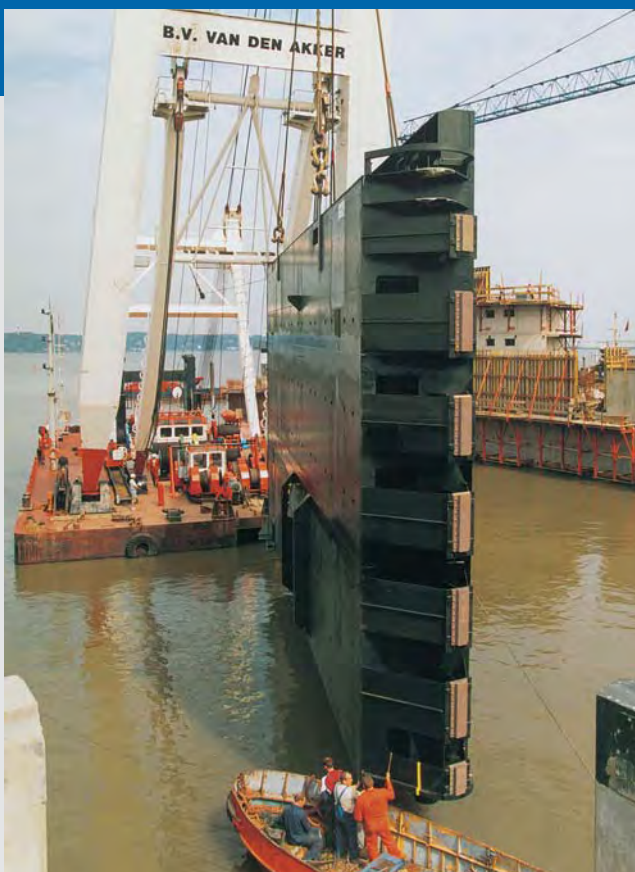
Mise en place d'une porte busquée - Colocación de la compuerta de inglete
