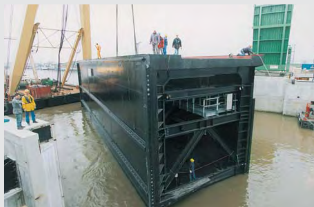
Mise en place - Transporte por flotación
